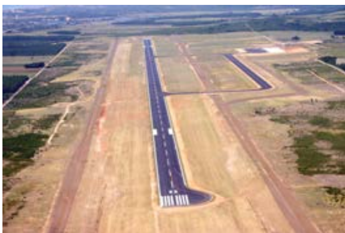
Figura 17: Vista aérea do Aeroporto Regional de Jaguaruna. Fonte: ARG, Jan/2006.
