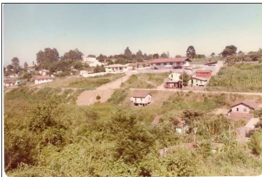
Foto 2 – Vista parcial da área onde foi construído o Parque do Lago, área central de Guarapuava, 1980
